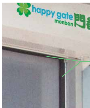
ส่วน Top frame ส่วน Side frame Air Tight Seal (option)
