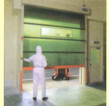
เมื่อรถโฟล์คลิฟท์ออกไป Shutter ปิดอัตโนมัติ
