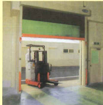
เมื่อรถโฟล์คลิฟท์เข้าใกล้ Shutter เปิดอัตโนมัติ
